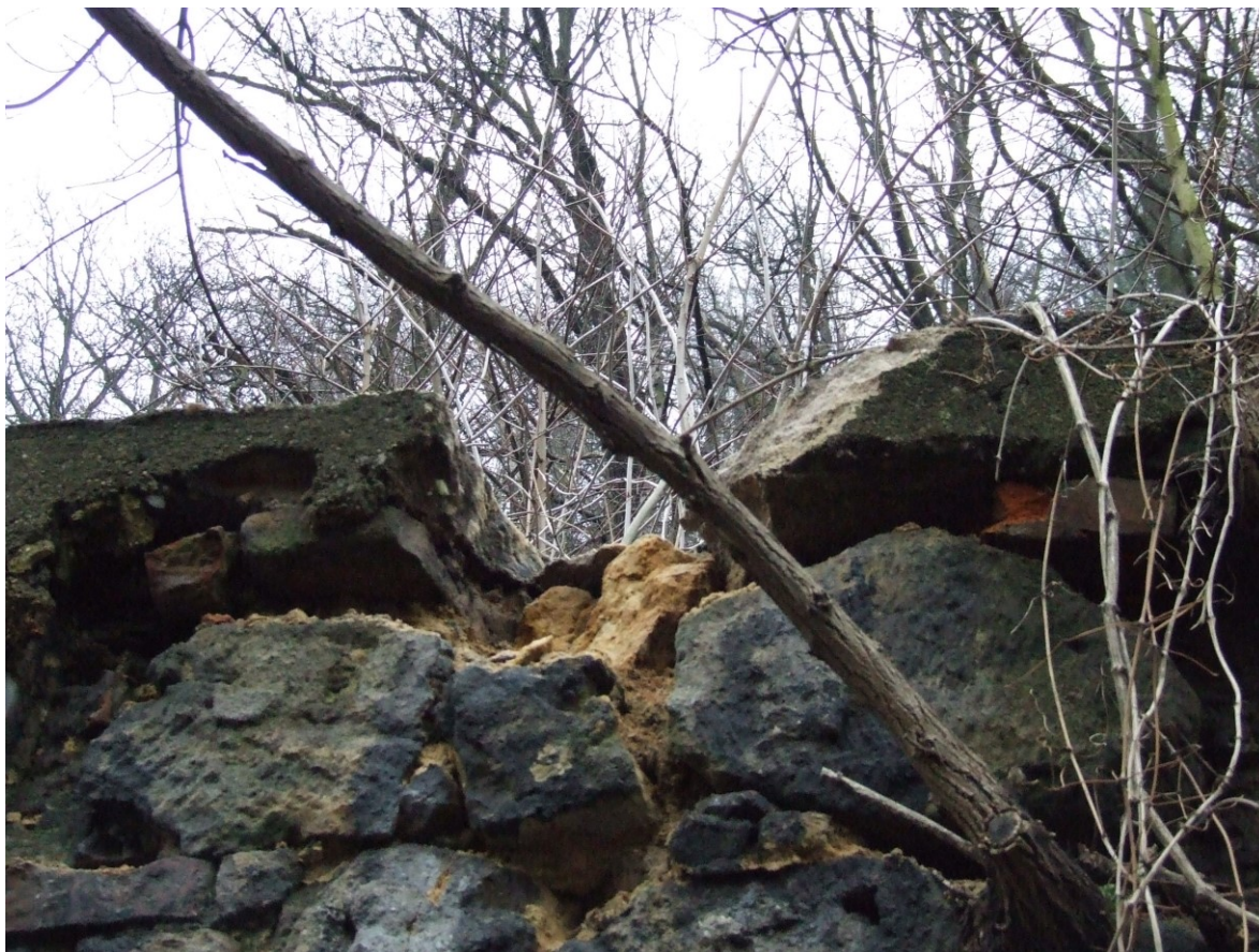
Detail narušení líce opěrné zdi:
