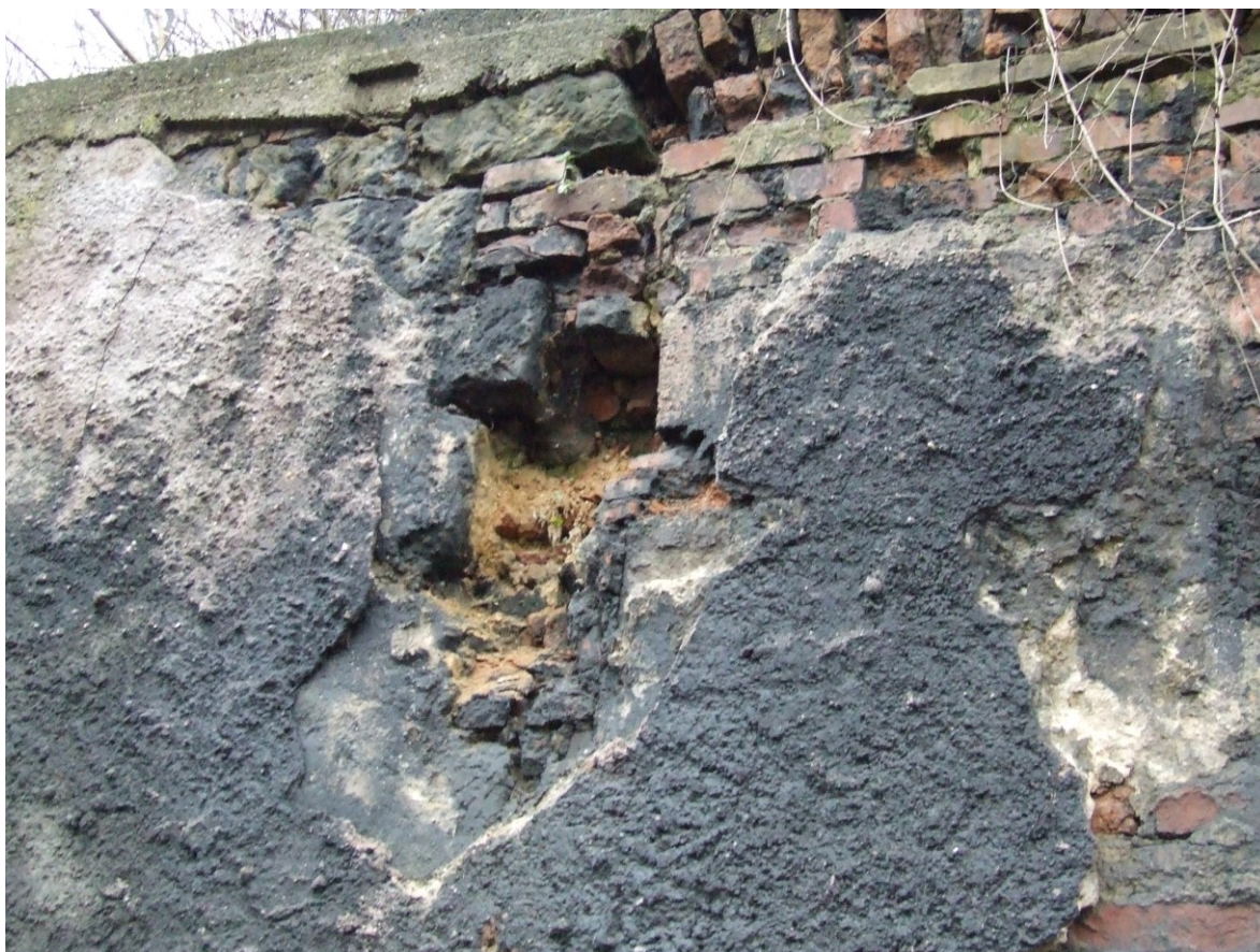
Detail narušení líce opěrné zdi:
